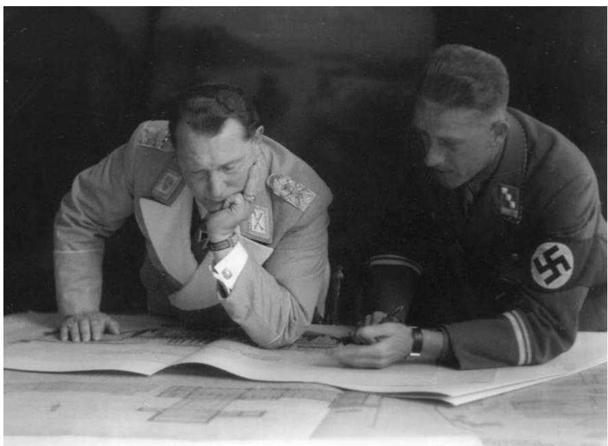
Bild 3: Hermann Göring und der Bürgermeister von Badgastein Sepp Wörther über Bauplänen der Gemeinde Badgastein (Photo Museum Bad Gastein): Erst Mitte Mai 1938 erhielt die Preussag den ad hoc Befehl Görings, den Goldbergbau in den Tauern weiterzuführen. Die folgende „abenteuerliche Vorgangsweise“ wird in Heft 1/2013 beschrieben, siehe auch die Ausführungen unter der Fußnote 2).
